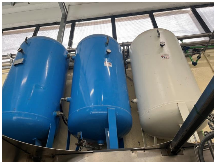
Figura 2: vecchi serbatoi in uso al momento
